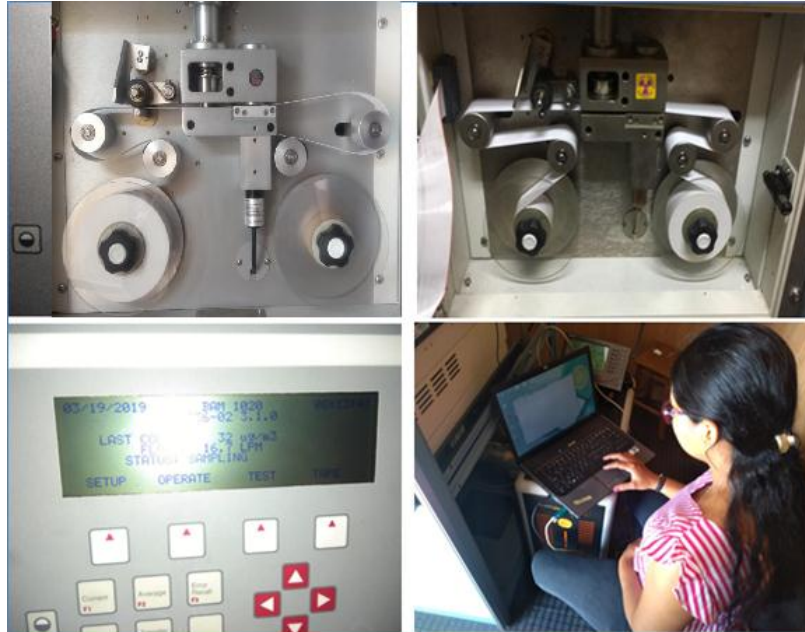
Ilustración 32 Mantenimiento Estación Ciudadela
