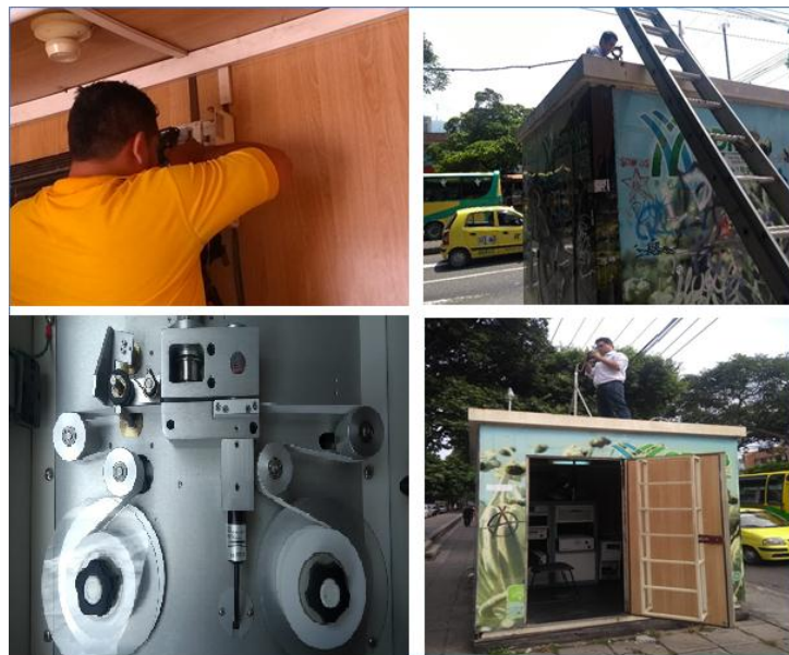
Ilustración 31 Registro fotográfico Mantenimiento Estación Cabecera
