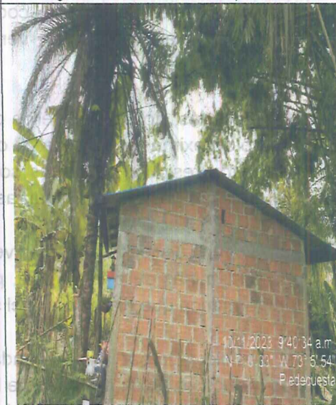
Fotografía 4. Vivienda existente en el lugar.
