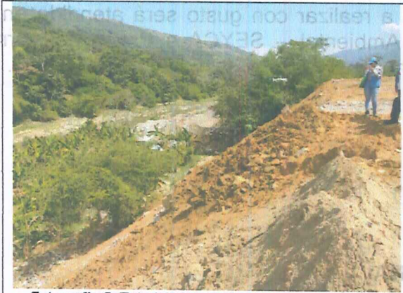
Fotografía 5. Talud Conformado por la disposición de RCD.
