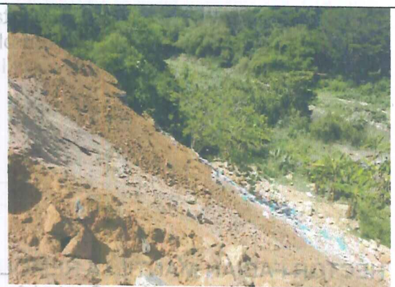
Fotografía 6. Talud Conformado por la disposición de RCD.
