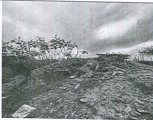
Fotografía 5. Parte inferior del talud.
