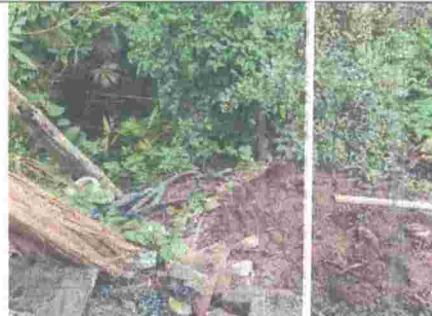
Fotografía No. 18. Disposición de RCD y residuos sólidos.
